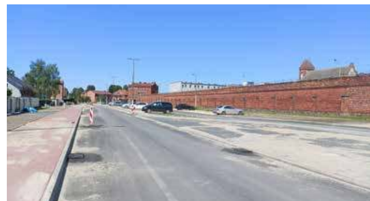
Ulica jest już prawie ukończona
