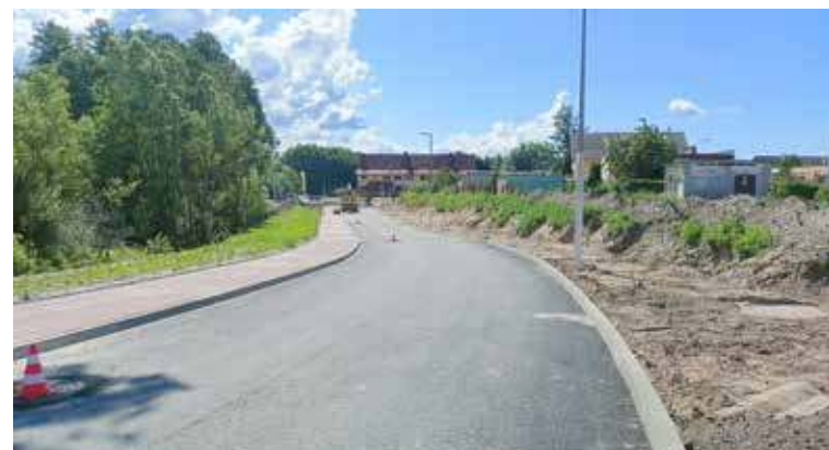
Remontowany był również łącznik z ulicą Nowogardzką
