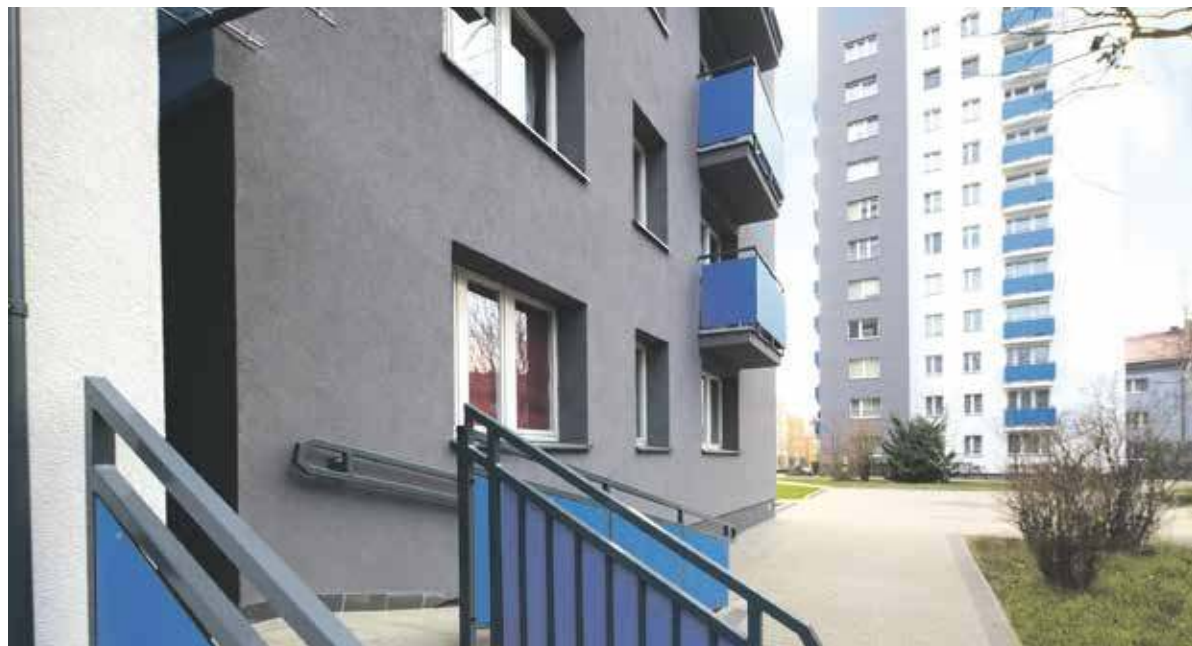
Ocieplone domy przy ul. Chorzowskiej
