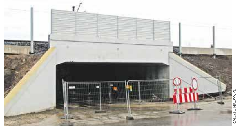
Po przebudowie pod wiaduktem mieszczą się dwa samochody
