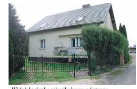
Widok budynku mieszkalnego od strony północno-zachodniej.
