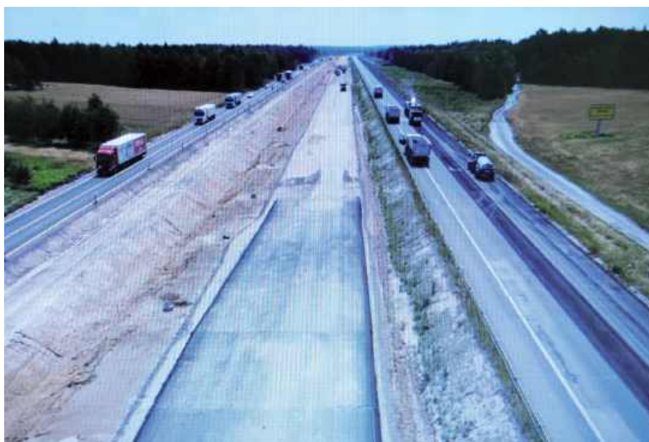
- Rozpoczęła się rozbiora dotychczasowej jezdni drogi krajowej - informuje GDDKiA
