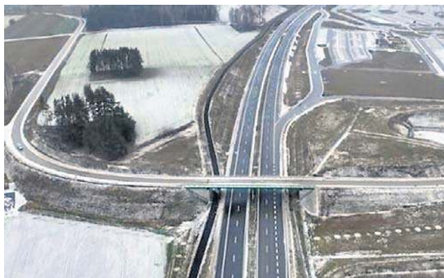
Oddany do ruchu odcinek drogi ekspresowej S19 od węzła Kuźnica do węzła Sokółka Północ
