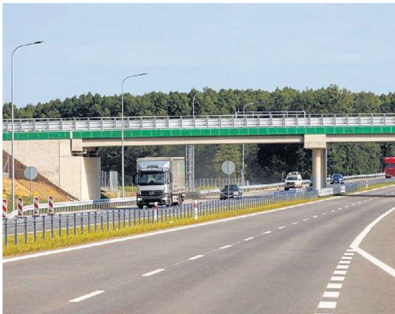
To najkrótszy odcinek S19. Trasa główna została udostępniona kierowcom. Nadal jednak trwają prace na kontrakcie
