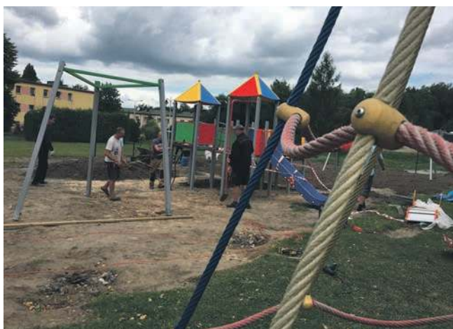
Plac przy Gwarków jeszcze w trakcie robót
