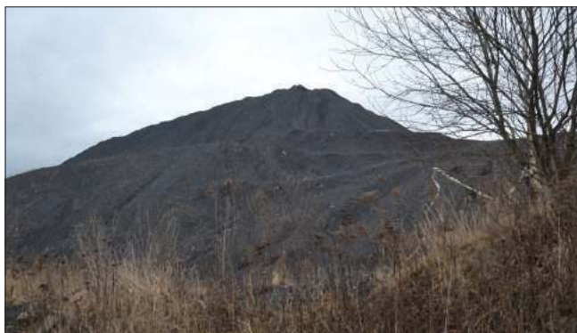
Część hałdy zostanie pokryta warstwą gliny, co ma ograniczyć emisję gazów pożarowych
