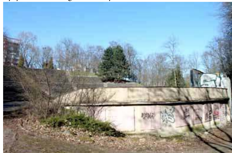
Z planowanych pierwotnie 12 milionów złotych na modernizację amfiteatru zaproponowane w przetargu przez wykonawcę koszty wzrosły do 27 milionów.
