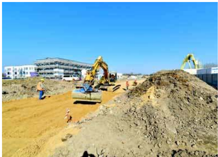
Trwa budowa odcinka północnej obwodnicy miasta
