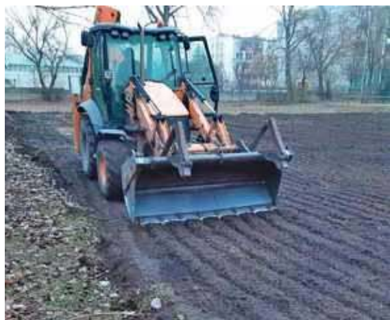
Prace przy „szóstce” trwają, a my już nie możemy do czekać się efektów!
