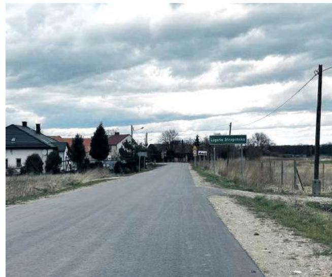
Wyremontowany odcinek drogi wykonany w 2021 roku
