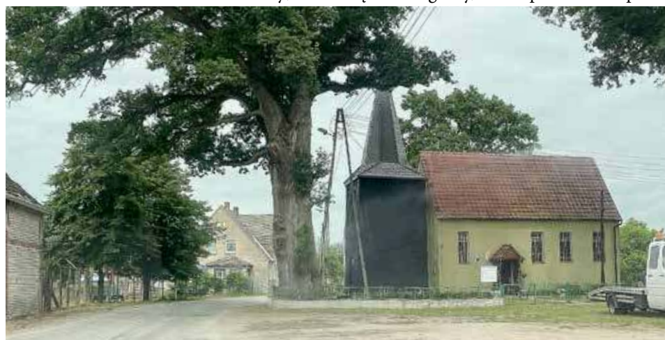
Zabytkowa dzwonnica kościoła
