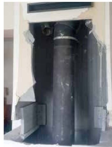
Felerny komin w trakcie akcji strażaków musiał zostać rozebrany
