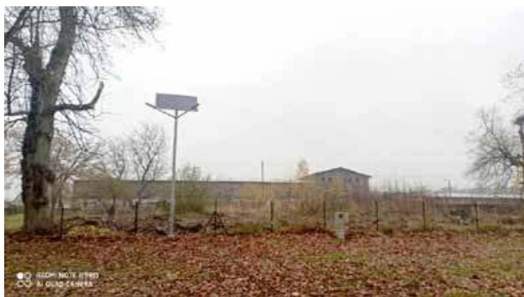
W Wieleniu Pomorskim zamontowano 3 duże latarnie solarne, które oświetlają plac zabaw i park
