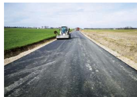
Droga w Sulnikowo - Skaszewo prawie gotowa źródło: gmina Gzy
