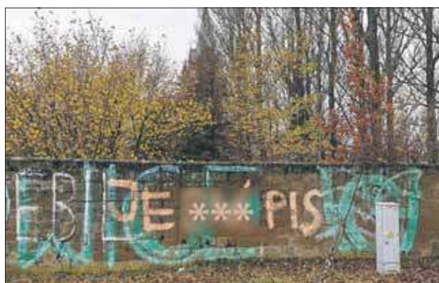
Kościelne ogrodzenie w Szczakowej
