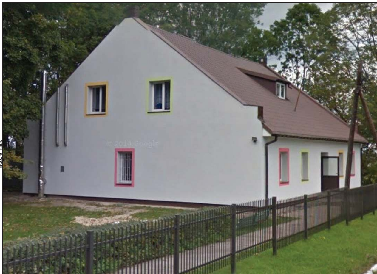
■ Budynek z zewnątrz wygląda dobrze. Został wyremontowany, zrobiono elewację i oświetlenie, ale stan ścian w środku sprawia, że nie nadaje się on już do dalszego remontu. Konieczne byłoby wybudowanie drugiego budynku szkoły
