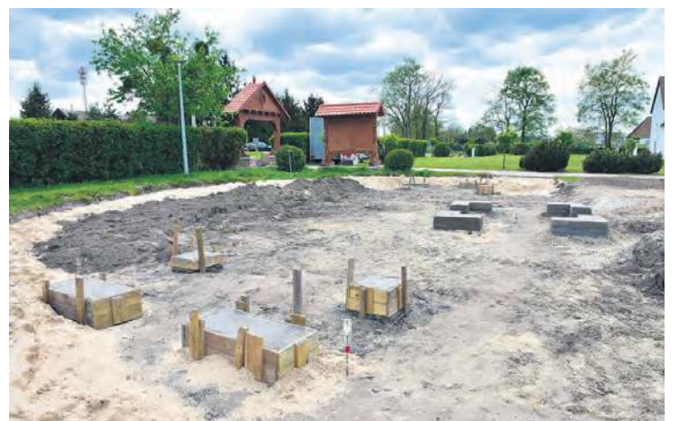
Widać już mniej więcej, gdzie będzie stała np. wiatra wypoczynkowa. Fot. (kt)
