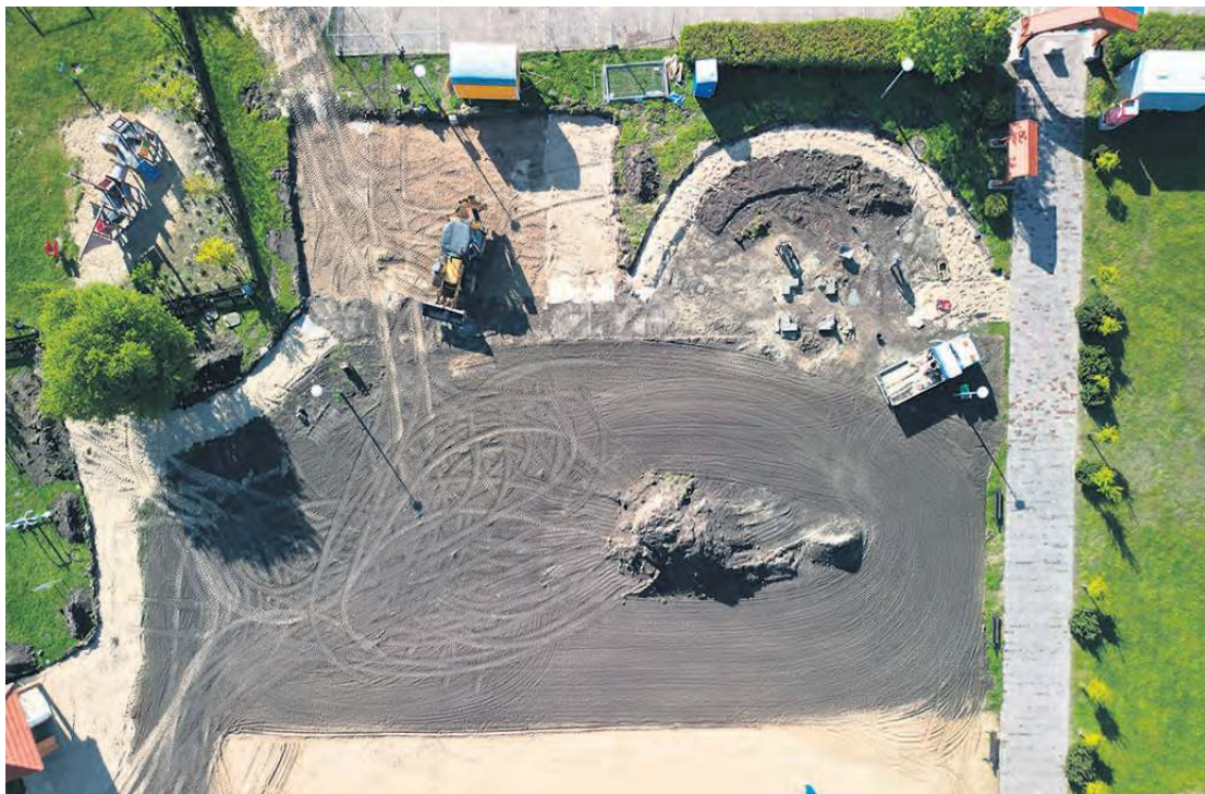
Zdjęcie z lotu ptaka dobrze pokazuje, na jak dużym terenie prowadzone są obecnie prace. Na dole znajduje się wąski pasek piaszczystej plaży. Zdjęcie Foto DRON Bystaw.
