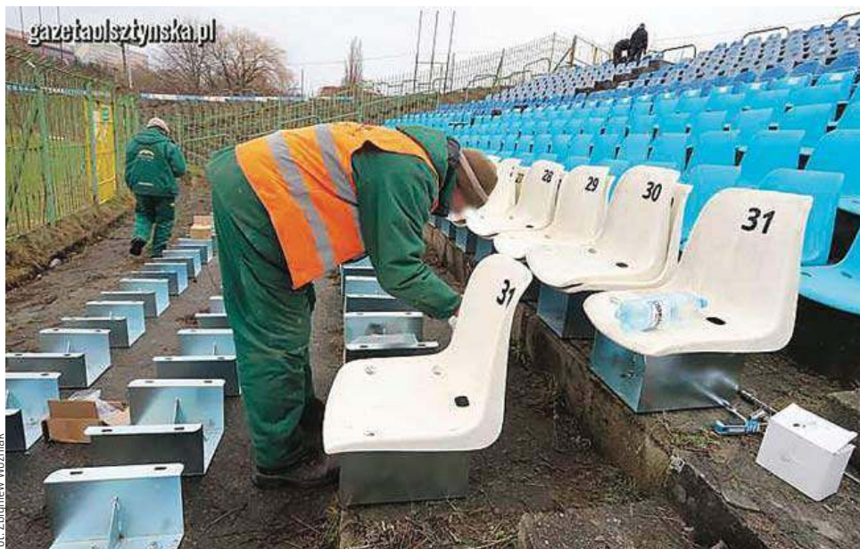
Montaż dodatkowych krzesełek na olsztyńskim stadionie
