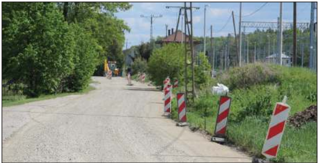
Położone zostaną dwie warstwy asfaltu, po uprzednim wyrównaniu tej ulicy tłuczniem
