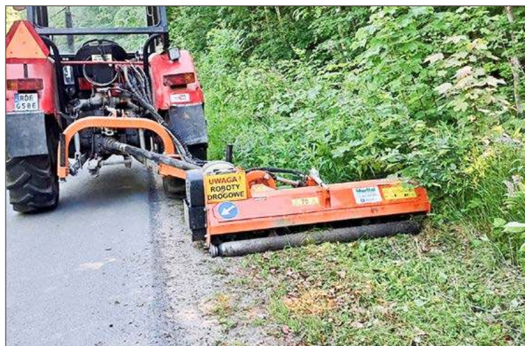
Radny ma zastrzeżenia do sposobu wykonywania prac.
