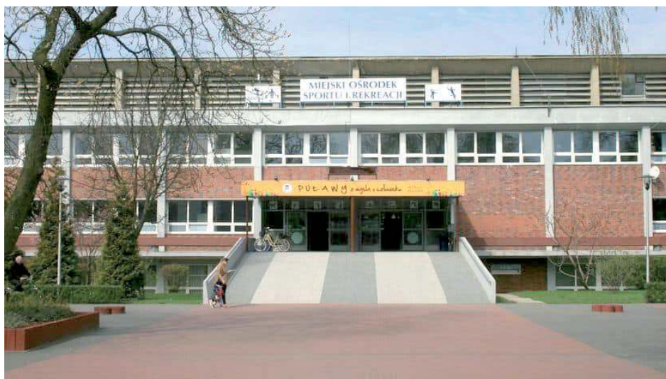
„Stara” hala sportowa służy mieszkańcom Puław od 1974 r. Została wybudowana według projektu znakomitego architekta Wojciecha Zabłockiego. Władze Puław nie ukrywają, że obiekt wymaga gruntownego remontu
