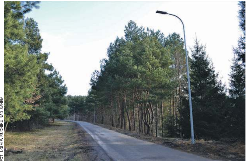
Pierwsze lampy LED wzdłuż drogi prowadzącej do cmentarza w Przedzelu zostały już zamontowane
