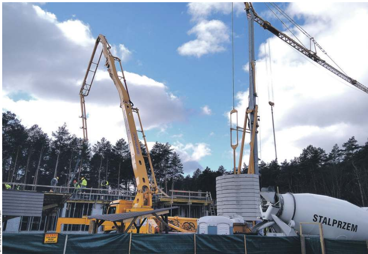
Trwają prace przy budowie trzeciego bloku przy ulicy Orzeszkowej w Stalowej Woli
