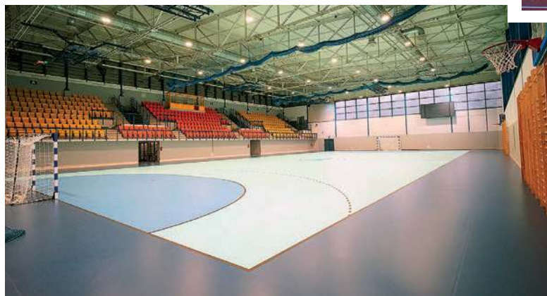
Hala sportowo-widowskowa przy ul. 17 Stycznia z nową nawierzchnią
