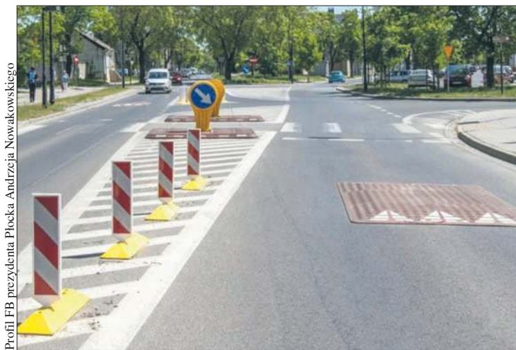
Na ul. Nowowiejskiego zostały zamontowane poduszki berlińskie spowalniające ruch samochodów przed przejściem dla pieszych
