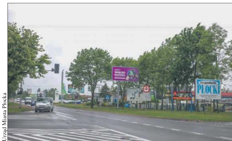
Na skrzyżowaniu ulic Wyszogrodzkiej i Harcerskiej powstanie rondo turbinowe
