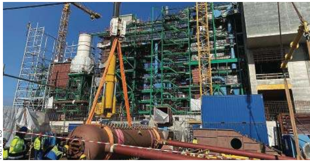
MPEC buduje ekociepłownię. Dzięki temu częściowo uniezależnimy się od węgla
