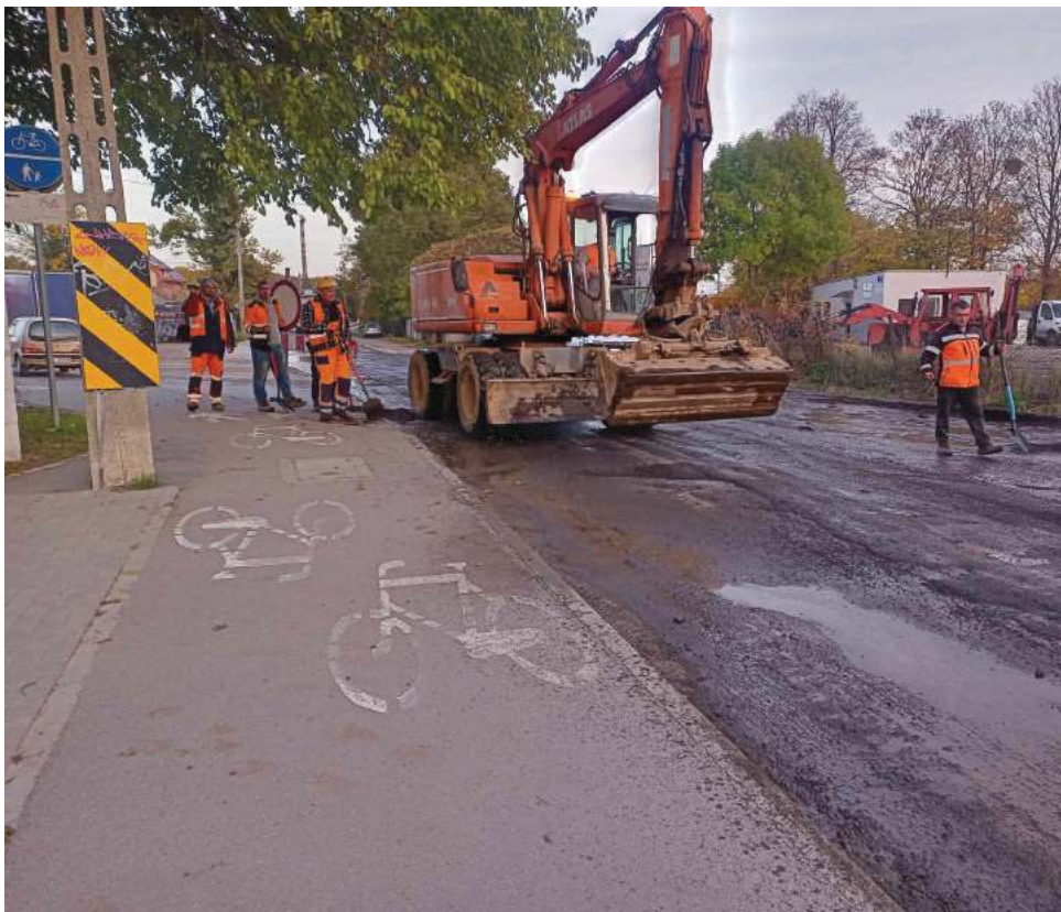
Remont ul. Sportowej właśnie się rozpoczął
