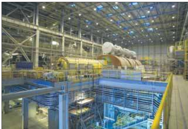
Prace na budowie bloku zostały wznowione
