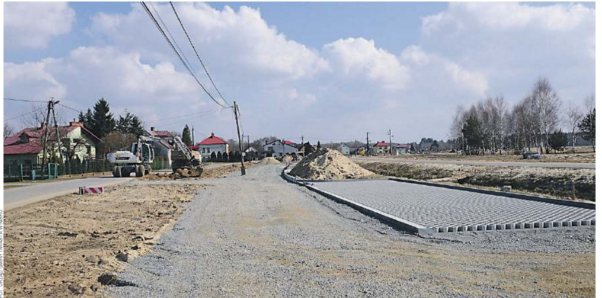
Wśród licznych inwestycji realizowanych w tym roku w gminie Nisku, jest m.in. zagospodarowanie terenu przy zbiorniku wodnym w Podwolinie
