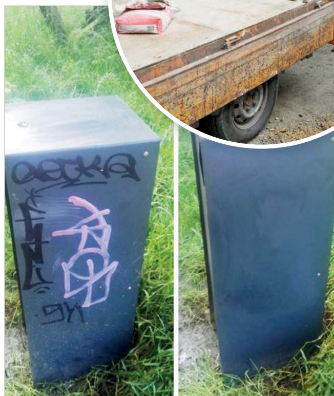
Wandale zniszczyli również kosz na śmieci. Pracownikom SKM-u udało się zmyć bazgroły.
