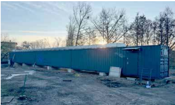
Obiekt przy ul. Zamkowej w budowie
