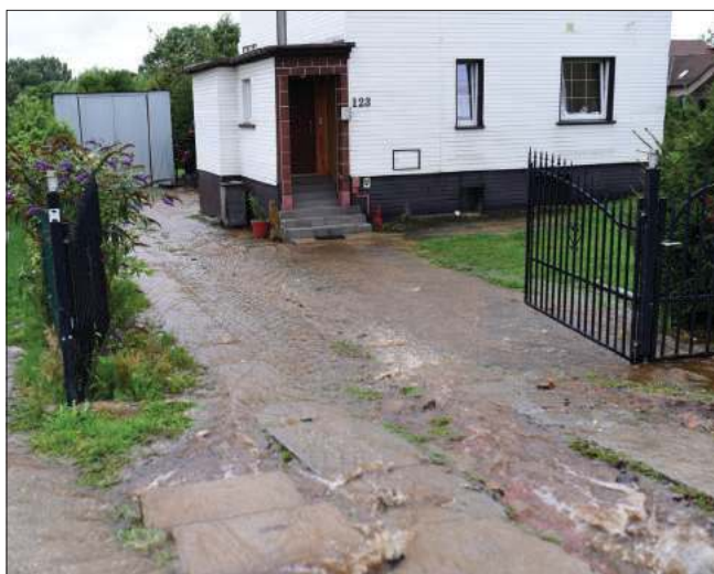
Wydobywająca się z uszkodzonej rury woda zalewała posesję nr 123 na ul. Pszowskiej i dwie w jej sąsiedztwie
