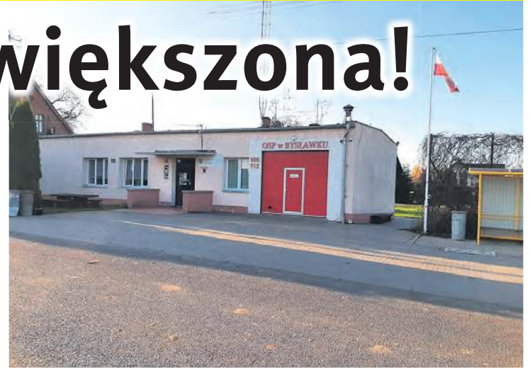
Świetlica doczeka się rozbudowy. Wykonawca na realizację remontu ma 7 miesięcy – licząc od 28 października br.
