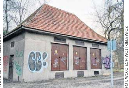
Stacja transformatorowa na Dojlidach
