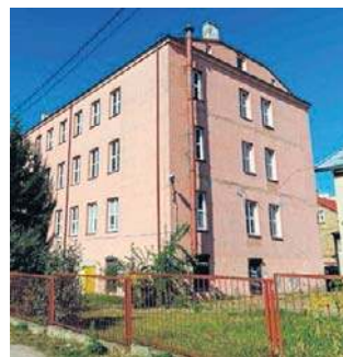
Budynek przy ul. Słonimskiej 8
