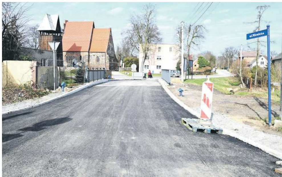
Do zakończenia budowy mostu w Strzeszowie pozostało ułożenie warstwy ścieralnej
