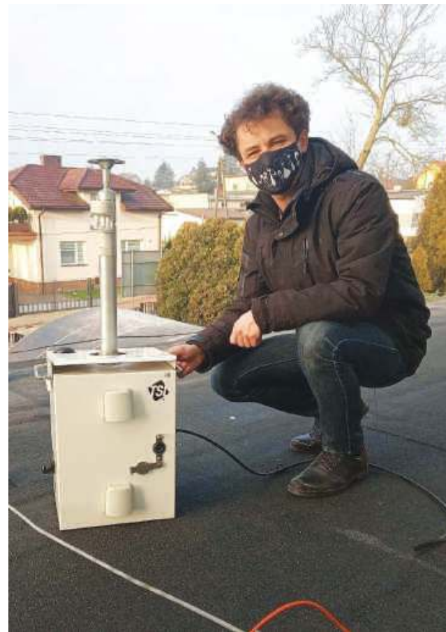
Montaż czujnika na dachu szkoły.
