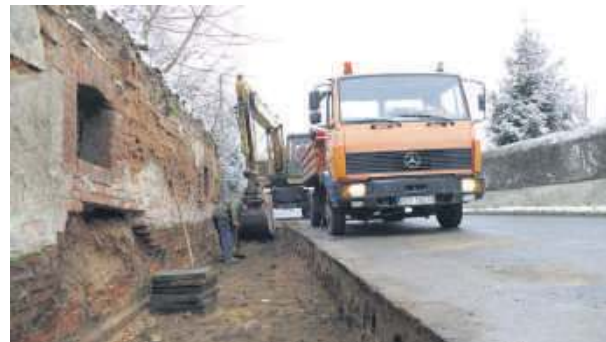
W Przewornie na ul. Ziębickiej, od skrzyżowania ulic Strzezińskiej i Pocztowej do skrzyżowania z ul. Okrężną, budowany jest nowy chodnik
