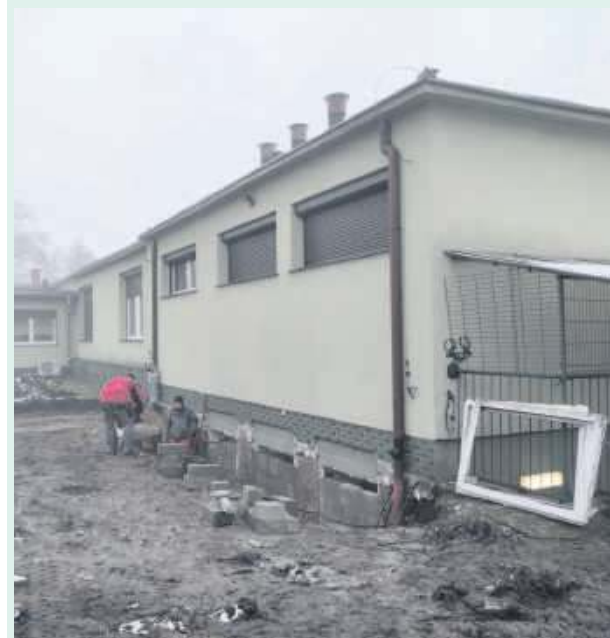
Nowe pomieszczenia poradni powstaną z tyłu istniejącego już budynku
