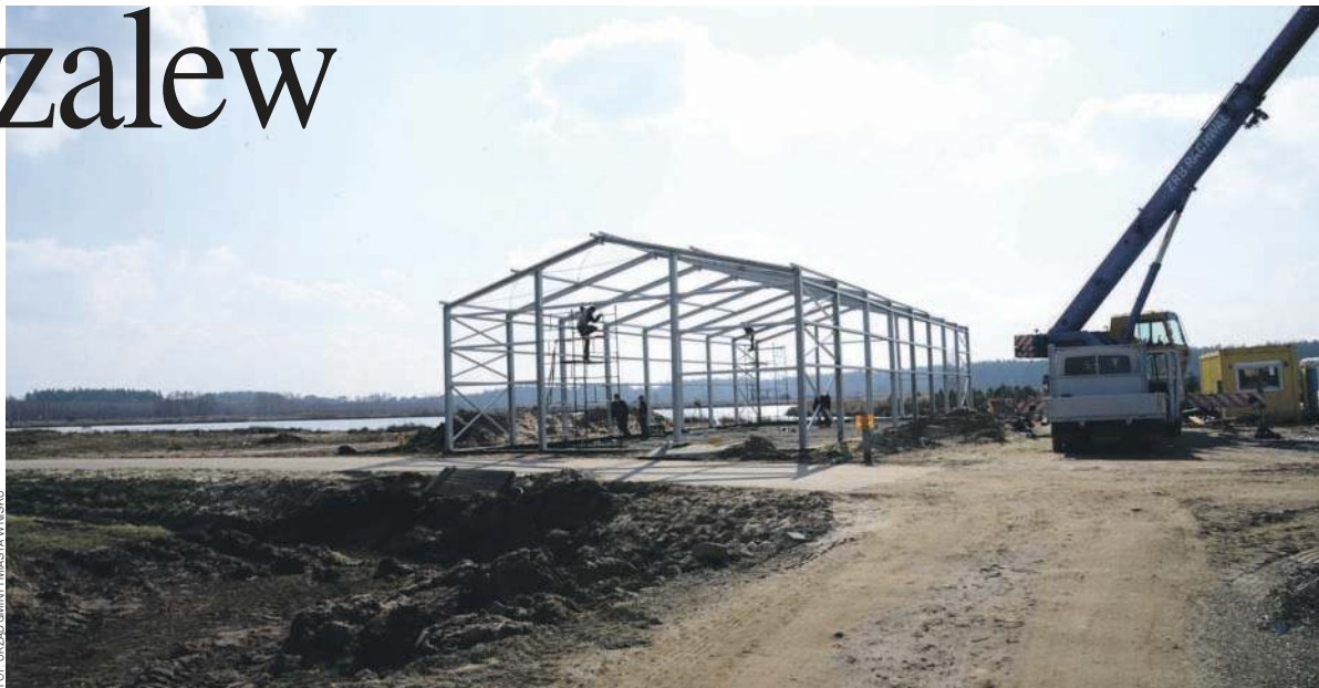
Już powstaje wypożyczalnia sprzętu wodnego oraz budynek gastronomiczny i sanitarny
