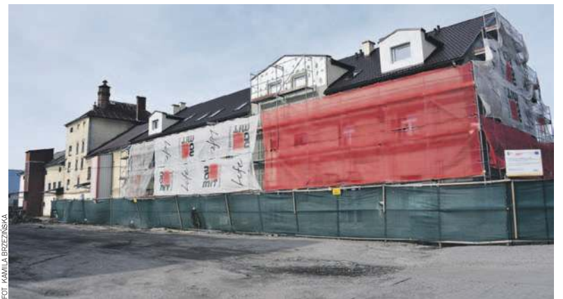
Remont dawnych Zakładów Drzewnych pod potrzeby Centrum Wsparcia ma potrwać do końca lipca br.
