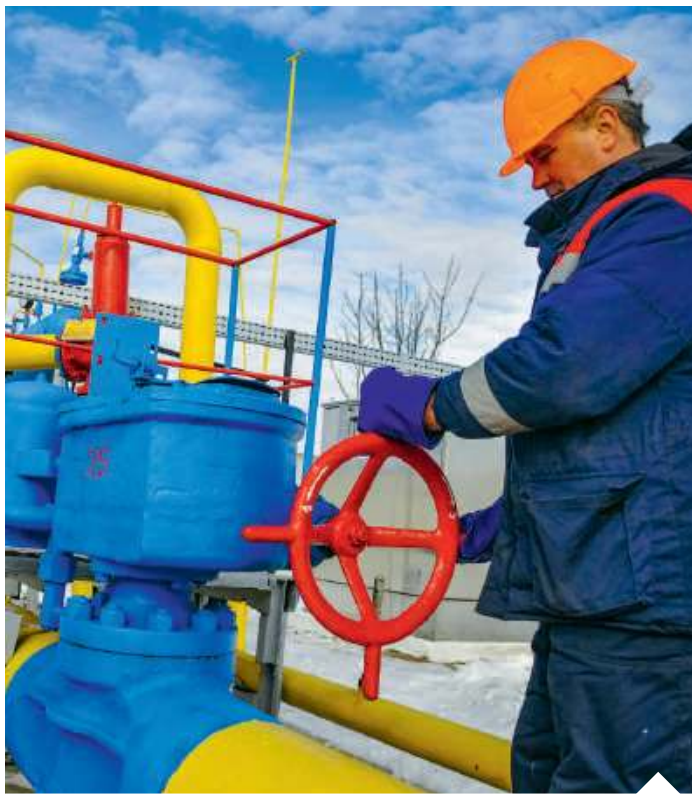
Co pewien czas Gazprom straszy Mołdawię odcięciem dostaw gazu | fot. PAVLO PALAMARCHUK/EPA/PAP
