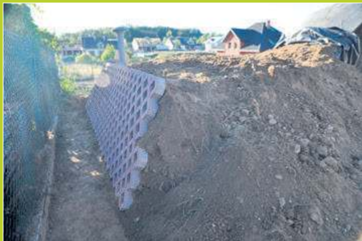
Tył ziemianki oraz boki zabezpieczono przed osuwaniem się ziemi. Na to przyszyły nasadzenia, m.in. bluszcz.
