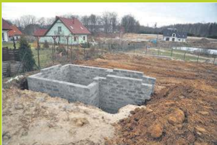
Ziemianka została wybudowana na głębokości 1,5 metra.
