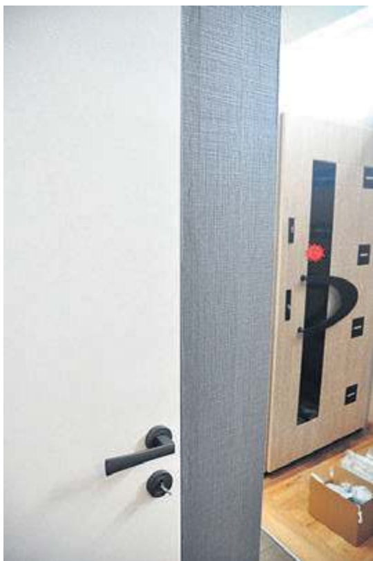
Klienci skłaniają się często ku drzwiom z ukrytymi ościeżnicami lub drzwiom bezprzylgowym, w których przypadku całość spaja we wspólną konstrukcję skrzydło i ościeżnicę.
