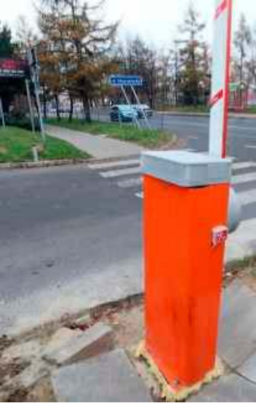
Czekające na podniesienie się szlabanu i wjazd na osiedle samochody tamują ruch na ulicy
