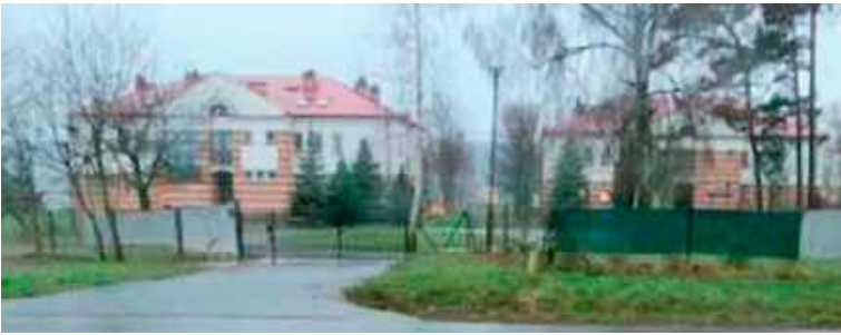
Największą przyszłoroczną powiatową inwestycją ma być termomodernizacja DPS w Świdniku
