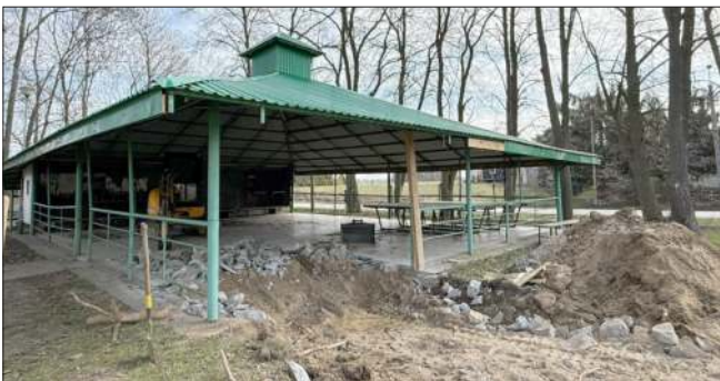
Remont już się rozpoczął.
