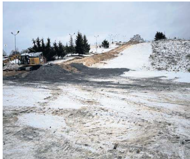
U stóp stoku w Leśnym Parku Kultury i Wypoczynku w Bydgoszczy trwają właśnie prace ziemne związane z wymianą części instalacji wodnej
