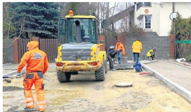
ZDMiKP realizuje program utwardzania ulic i kolejne miejsca na Osowej Górze zyskują nowe nawierzchnie
