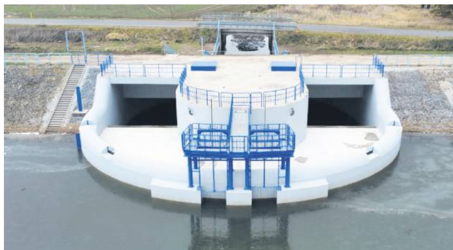
Zbiornik zalewowy na Krynce, który pełni funkcję przeciwpowodziową, jest już zalany wodą. Foto: Wojciech Poręba
