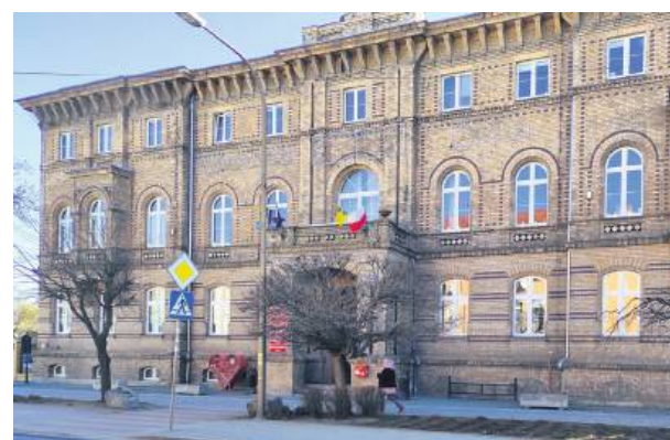
Zabytkowy budynek urzędu przy ulicy Ząbkowickiej w Strzelinie już za kilka miesięcy zmieni swoje przeznaczenie
