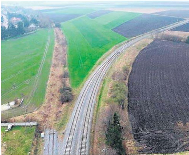
Po linii Łagiewniki - Kobierzyce pozostał tylko zarośnięty ślad po starych szynach. Teraz odbudują ją od podstaw
