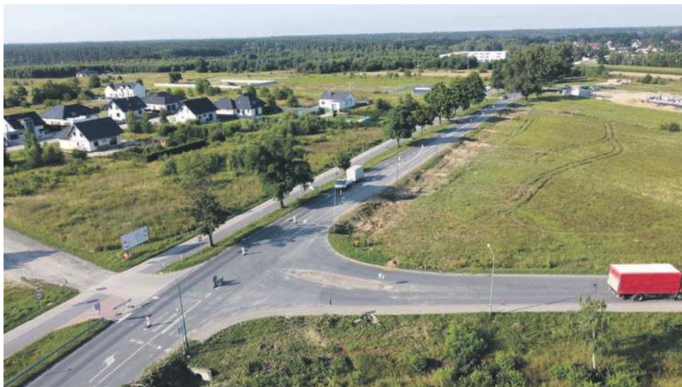
Drzewa wycięto wzdłuż ulicy Oławskiej (po prawej stronie). Powstanie tam dodatkowy pas do skrętu w prawo z ulicy Belgijskiej
