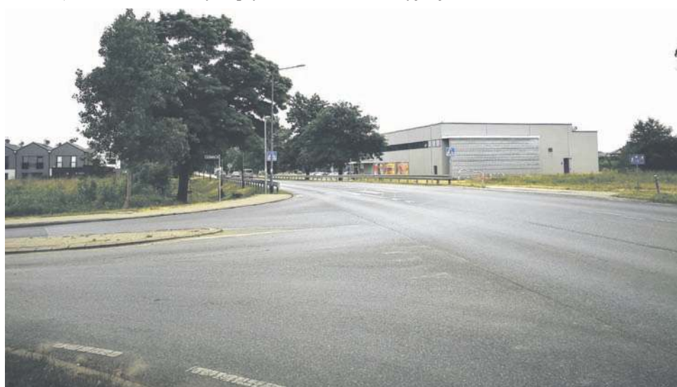
Na tym skrzyżowaniu powstaje rondo - ten widok już wkrótce przejdzie do historii
