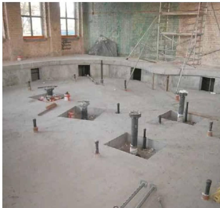
Niecka basenu sportowego została uzbrojona
