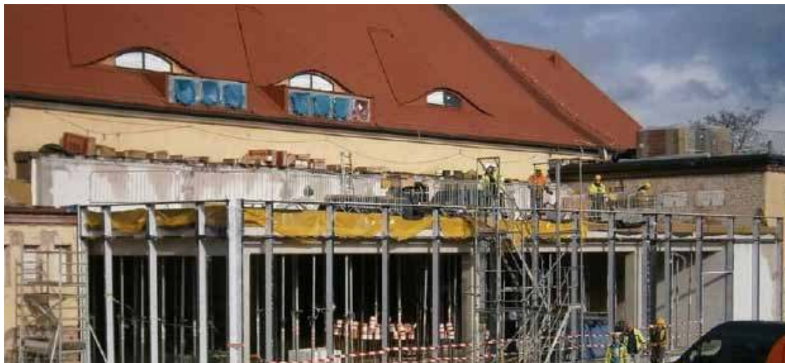
Na pływalni praca wre
