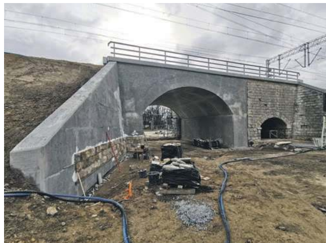
Wiadukt na ul. Siennej w Chrzanowie
