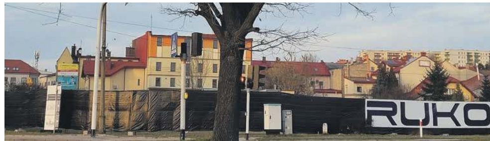
Plac budowy ogrodzony
