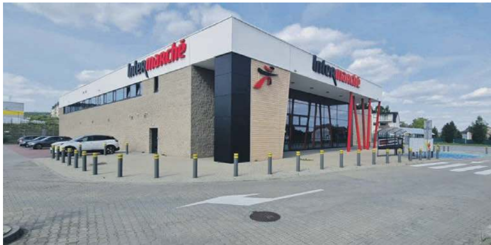
Supermarket Intermarche w Krzeszowicach
