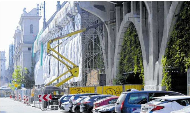
• Remontu wiaduktu Mostu Poniatowskiego FOT. KUBA ATYS / AGENCJA WYBORCZA.PL
