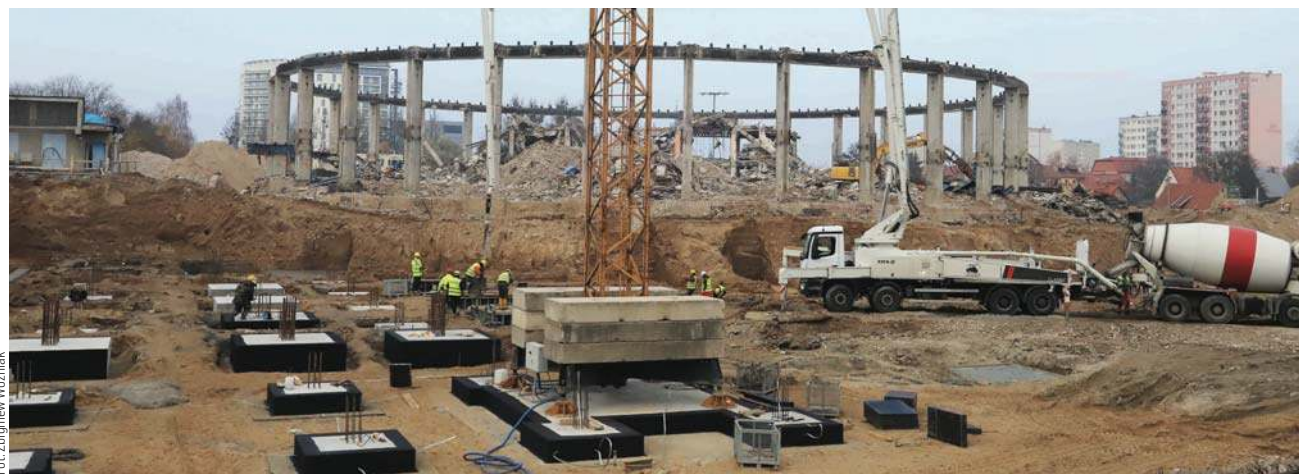
Państwowa Inspekcja Pracy skontrolowała plac budowy hali Urania
